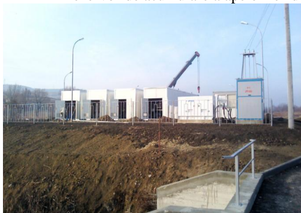
Stația de epurare din or. Călărași
