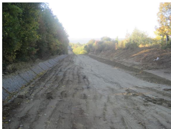
Drum în reconstrucție
